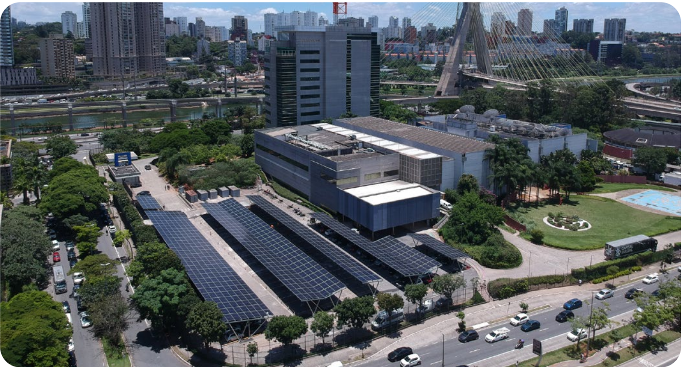
Carport SP • novas placas solares instaladas na sede de São Paulo
