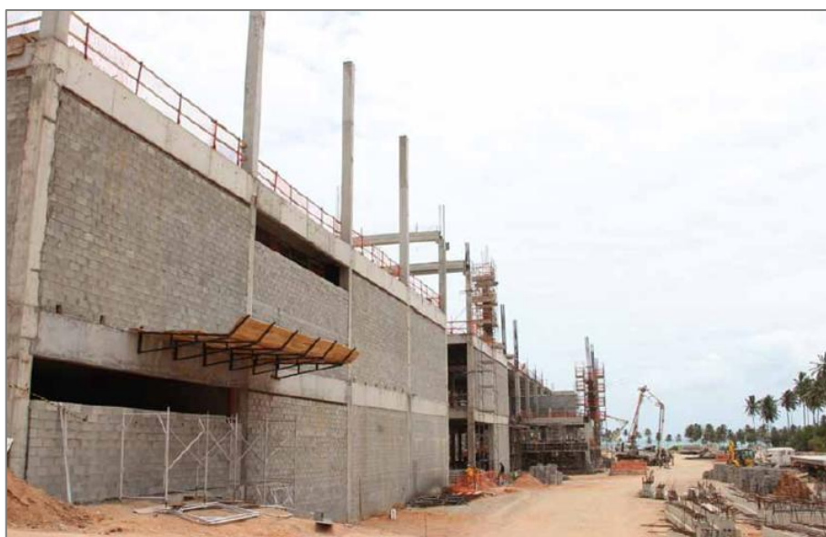
Parque Shopping Maceió – Construção (em outubro de 2012)
