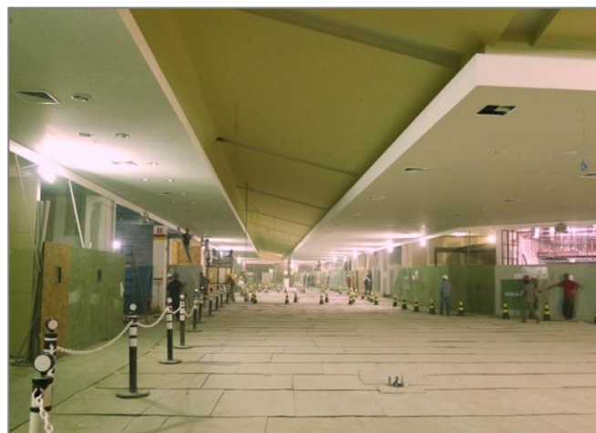
Expansão VI RibeirãoShopping – Construção (outubro 2012)
