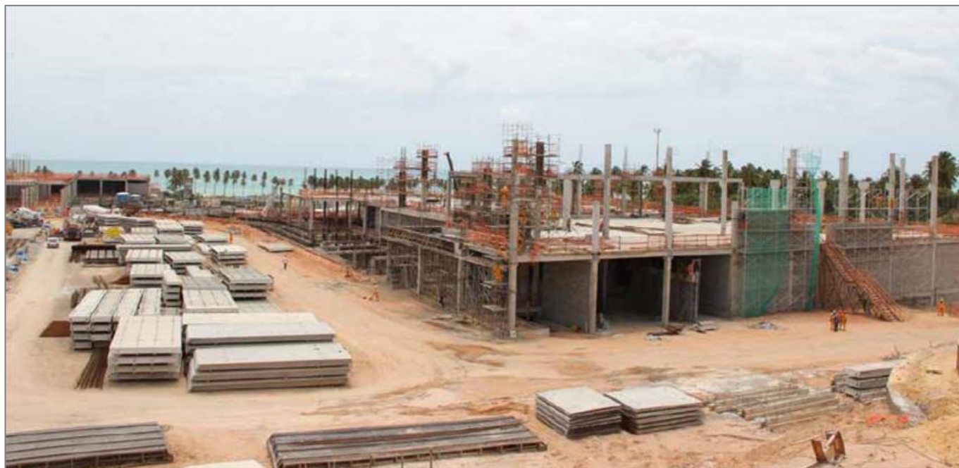
Parque Shopping Maceió – Construção (em outubro de 2012)
