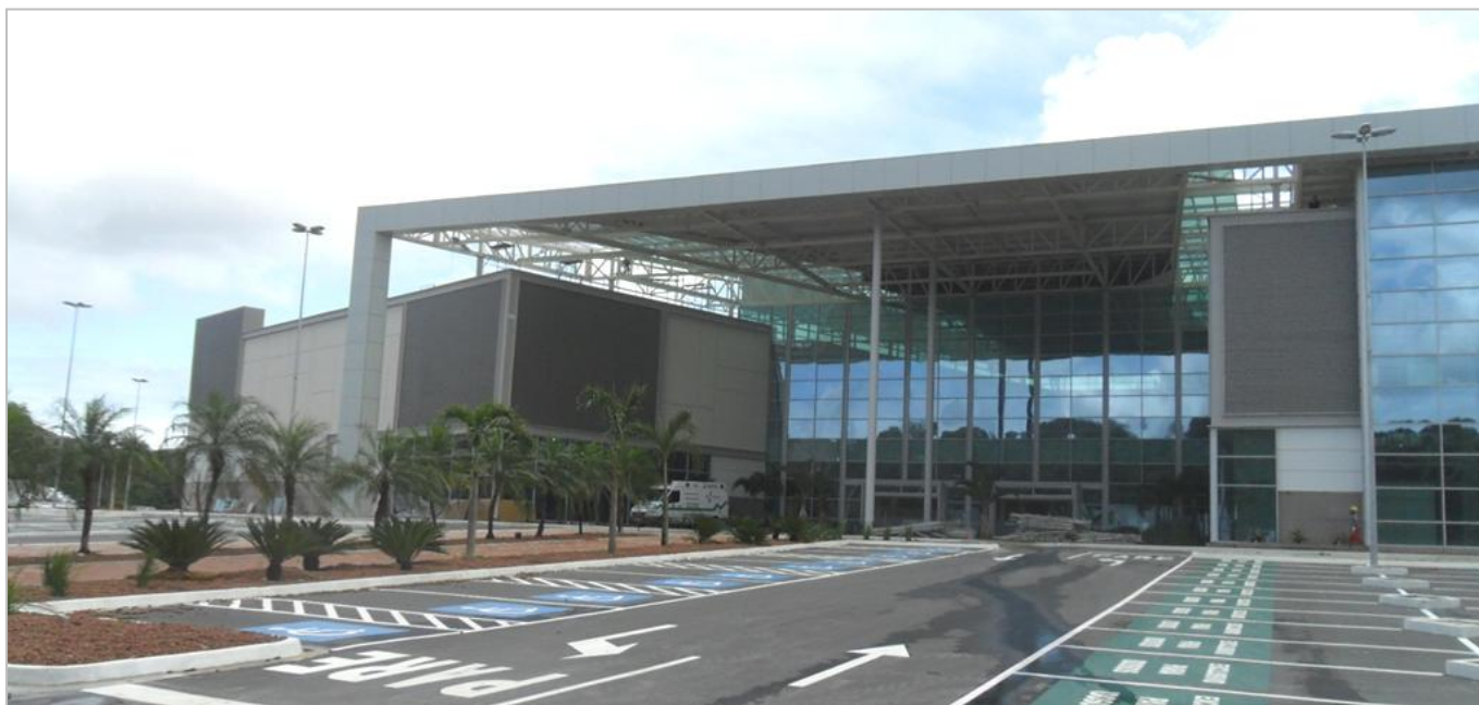
ParkShoppingCampoGrande – Construção (em outubro de 2012)
