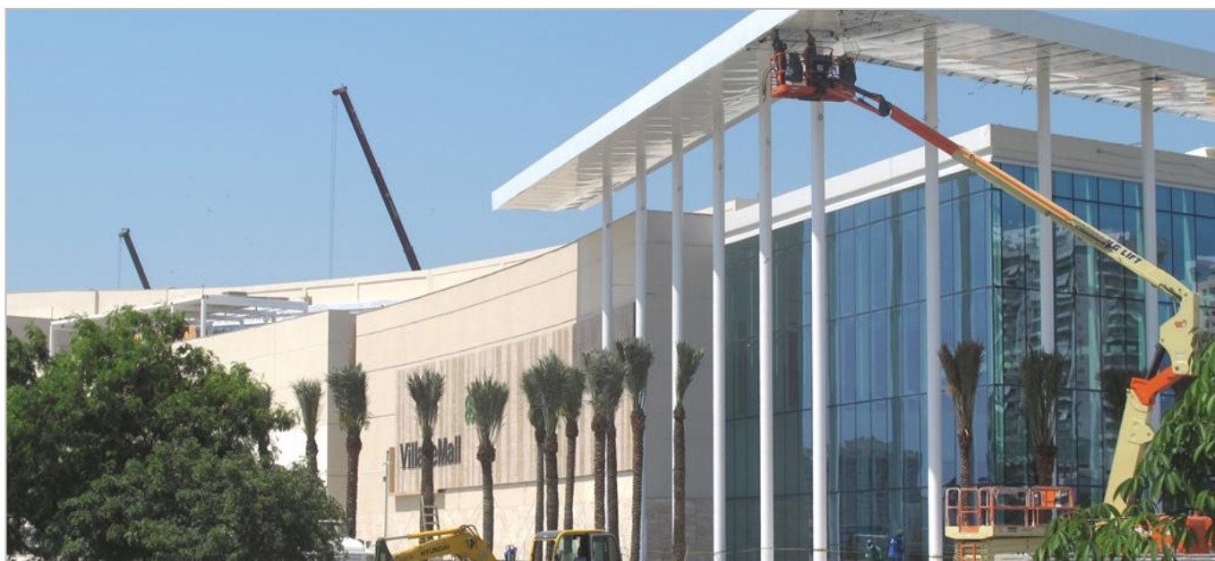
VillageMall – Construção (em outubro de 2012)
