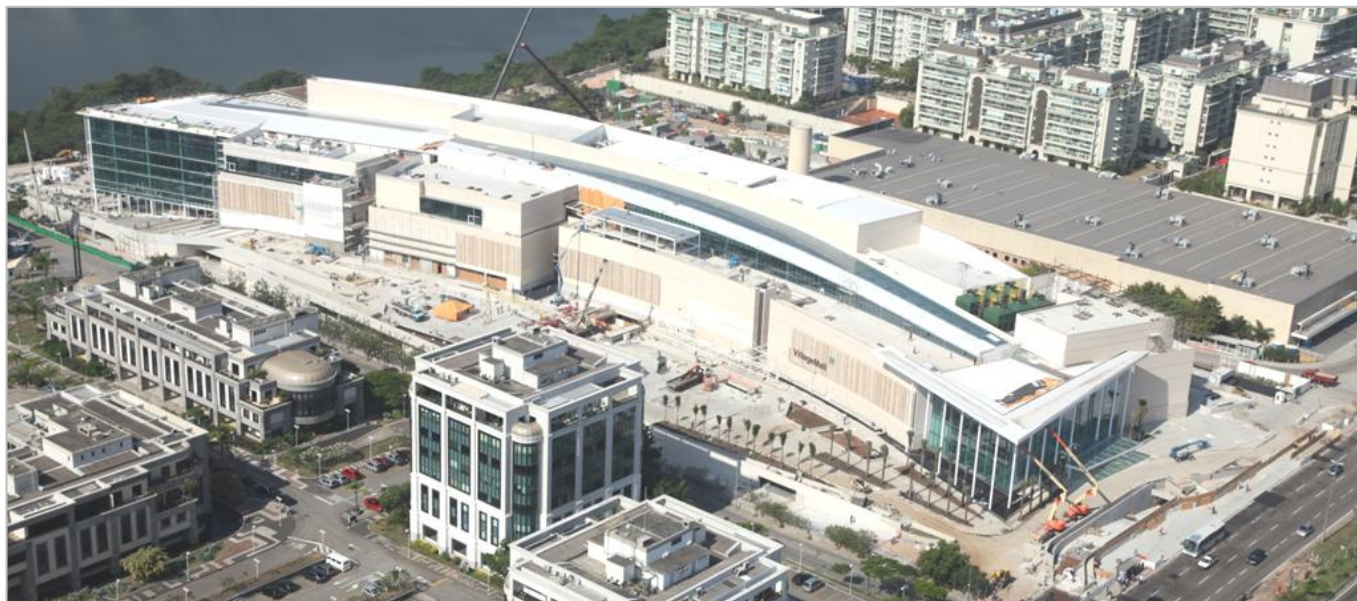
VillageMall – Construção (em outubro de 2012)
