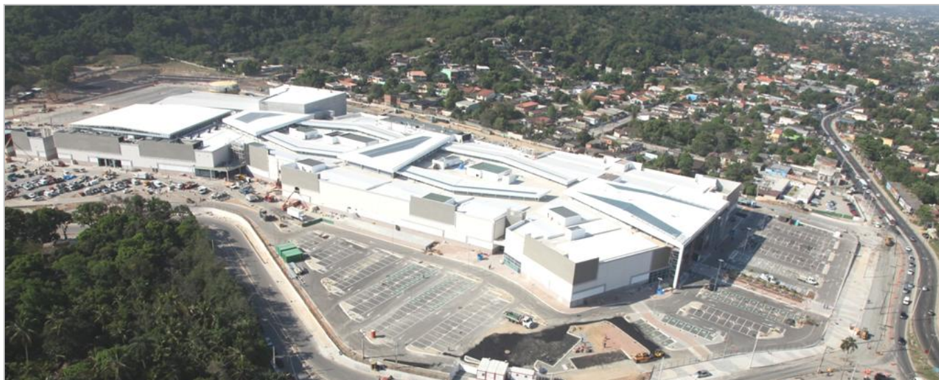
ParkShoppingCampoGrande – Construção (em outubro de 2012)
