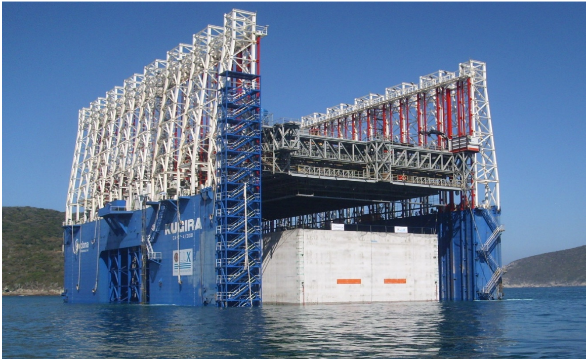
Execução do 1º dique de concreto
