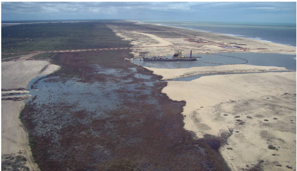
Dragagem em execução no TX2
