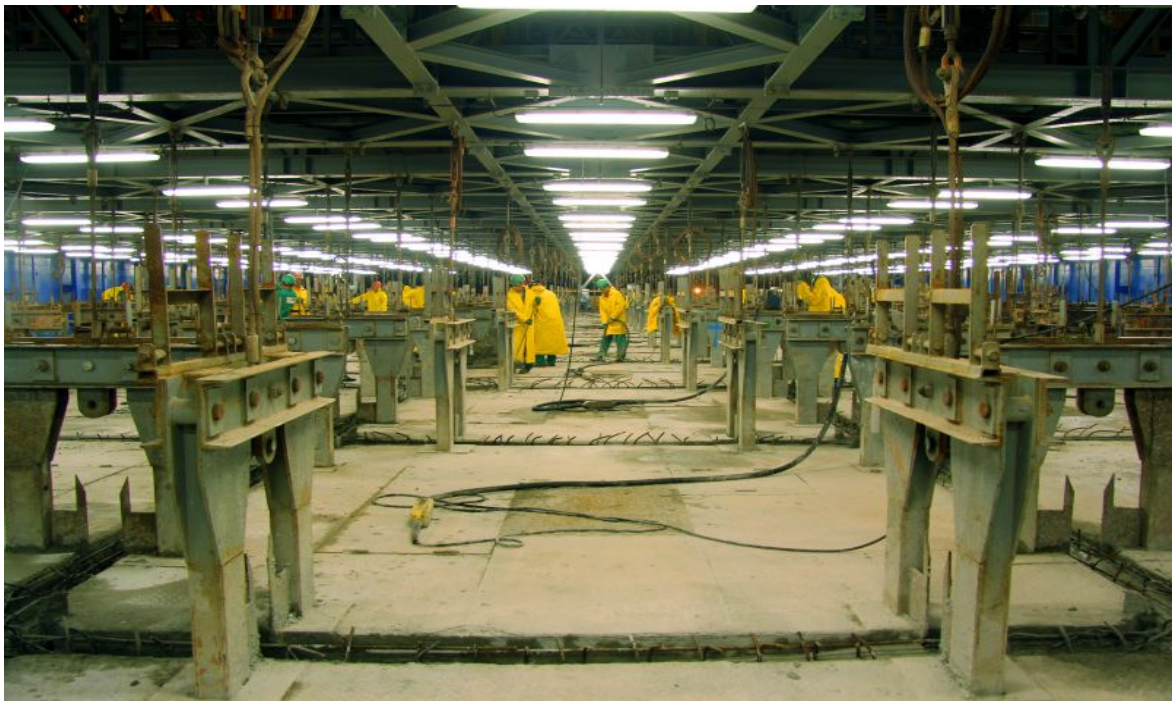
Montagem da armação do 3º dique de concreto em evolução
