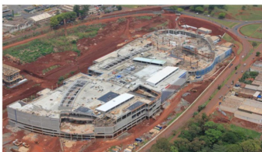
Obras do projeto do Boulevard Londrina
