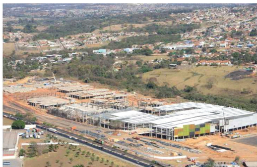
Obras do projeto do Passeio das Águas
