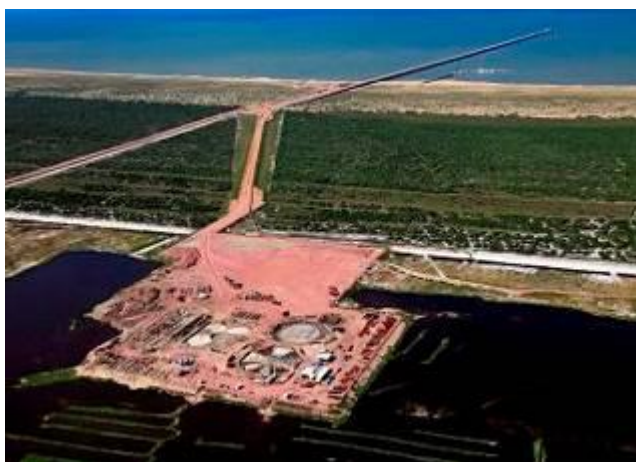
Visão aérea da área da filtragem do minério de ferro
