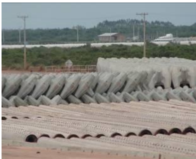
Estocagem de core-locs
