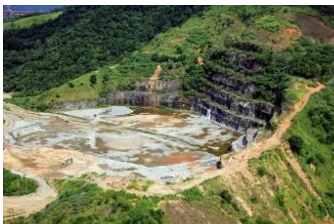
Vista aérea da área do pátio de estocagem
