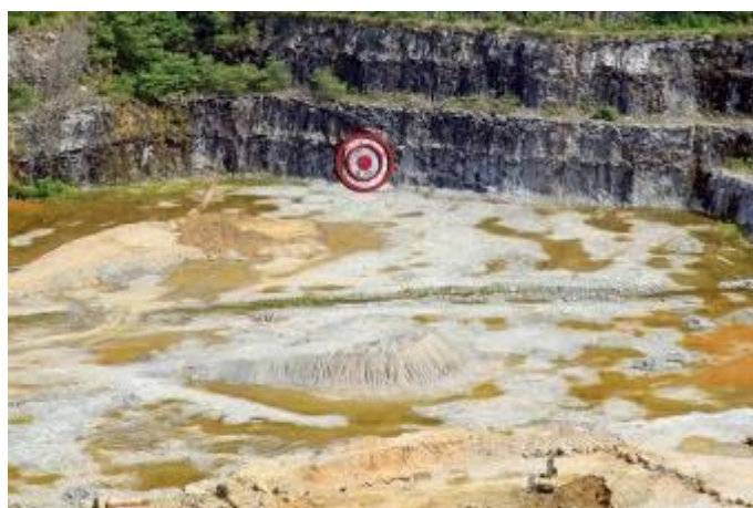
Marcação do emboque do túnel
