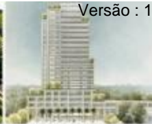
RESIDÊNCIA CIDADE JARDIM
