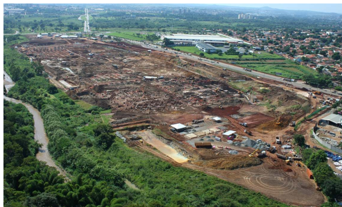
Obras do Projeto do Passeio das Águas
