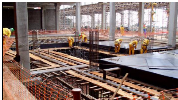
Obras do Projeto do Boulevard Londrina
