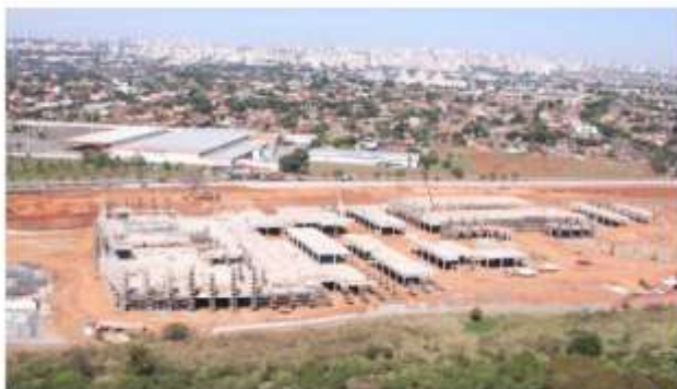
Obras do projeto do Passeio das Águas
