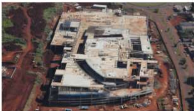
Obras do projeto do Boulevard Londrina
