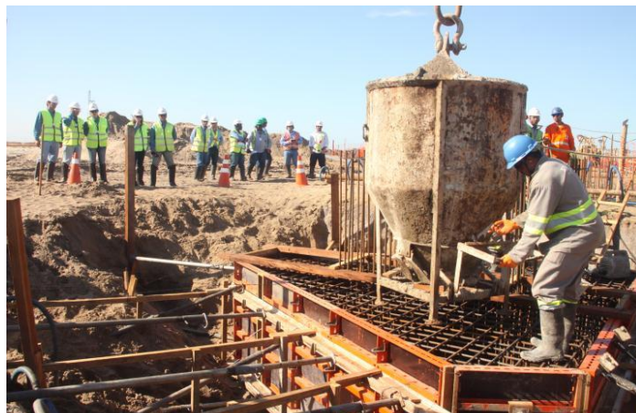
Fundações dos edifícios industriais
