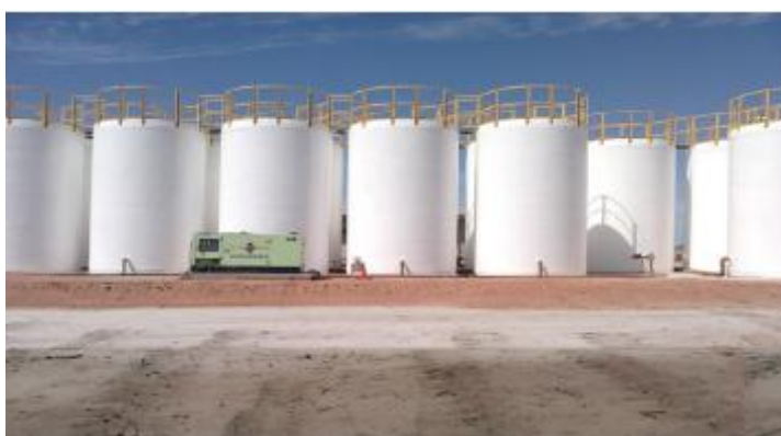
Estação do tratamento de esgoto
