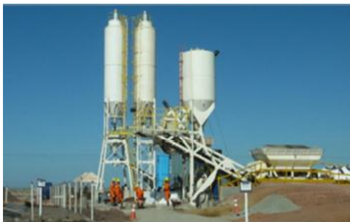
Montagem da central de concreto de 80m 3
