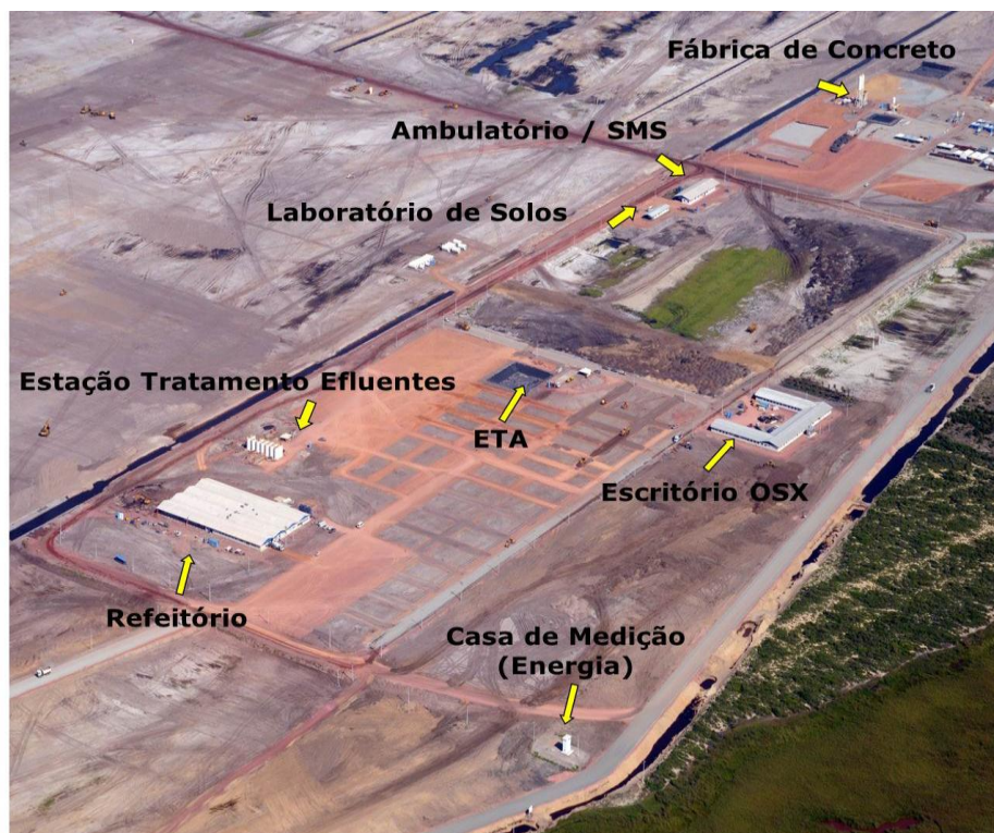
Vista aérea do Canteiro de Obras
