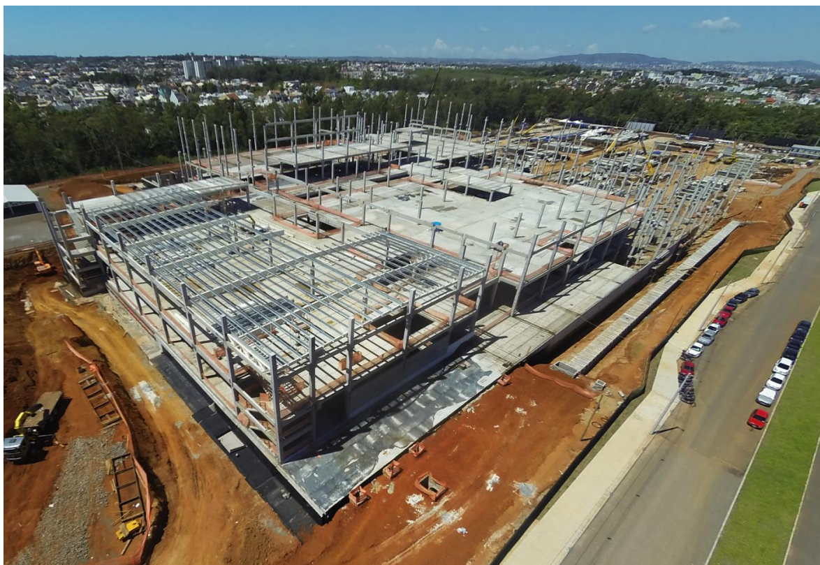
ParkShoppingCanoas em construção (Mar-16)
