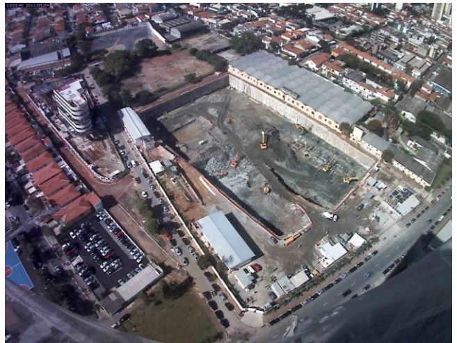
Obras EZ Tower - 04.05.2012
