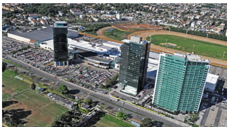
Complexo BarraShoppingSul: Cristal Tower, Diamond Tower, Résidence du Lac e BarraShoppingSul
