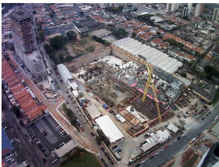
Foto do Canteiro de Obra EZTower dia 08 de Novembro de 2012
