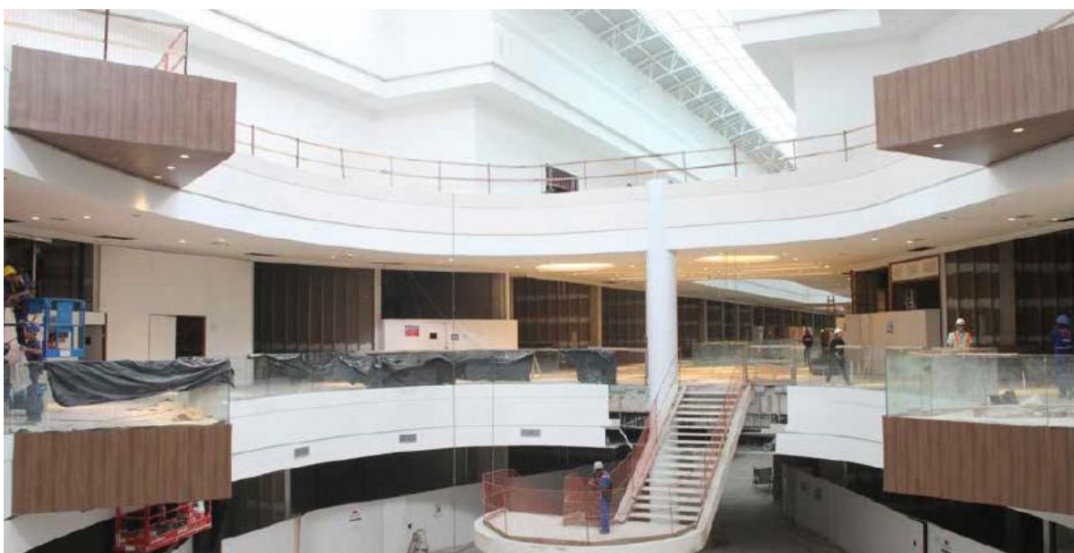
Parque Shopping Maceió – Obra (setembro 2013)
