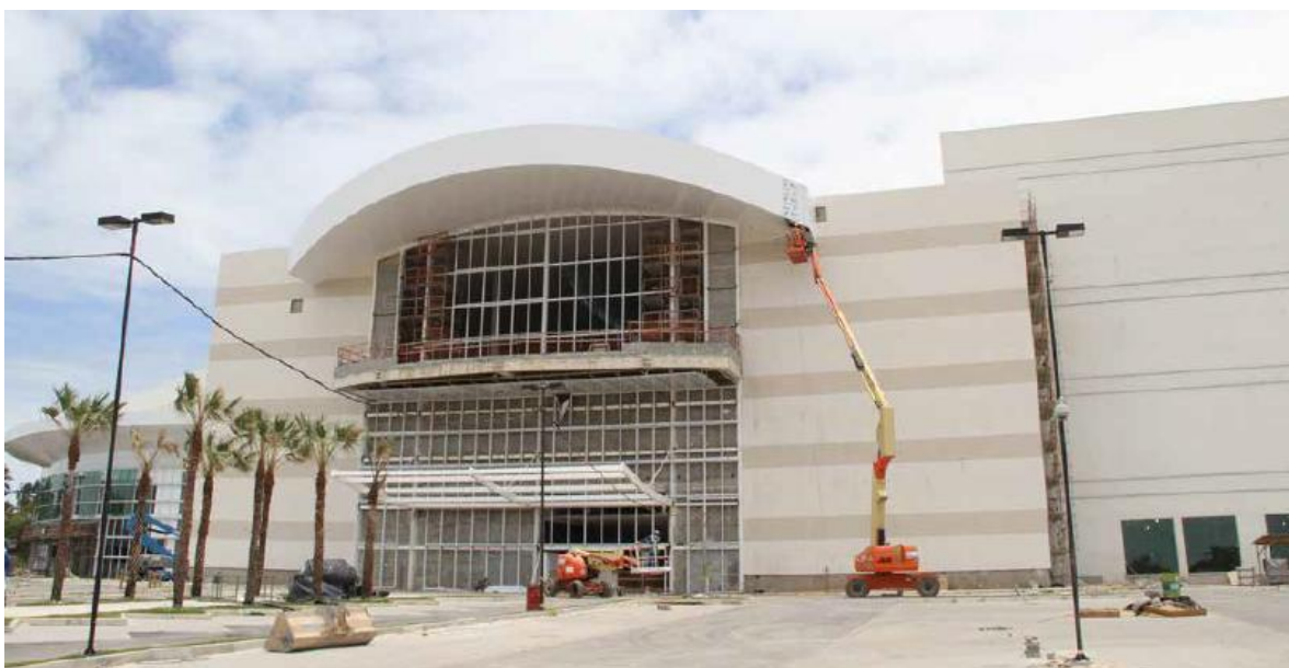
Parque Shopping Maceió – Obra (setembro 2013)
