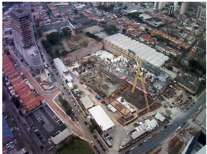
Foto do Canteiro de Obra EZTower dia 08 de Novembro de 2012
