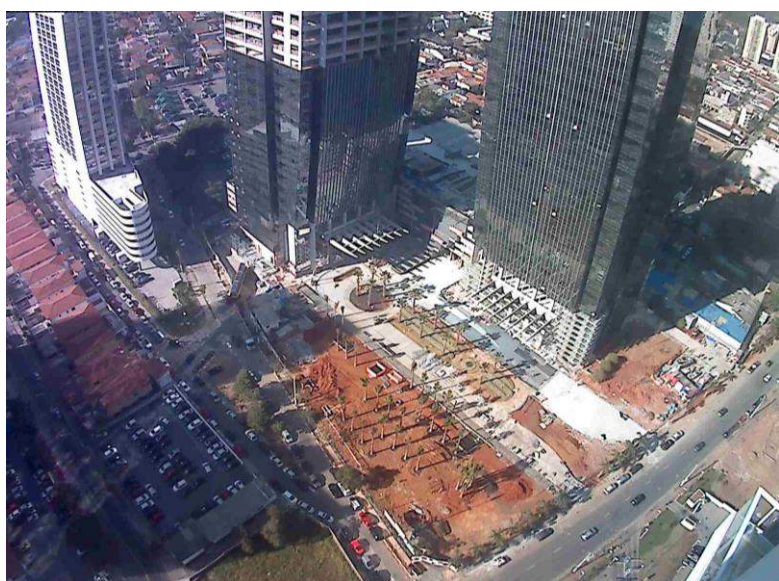
Foto Área de Acesso - EZ Towers em 11 de agosto de 2014
