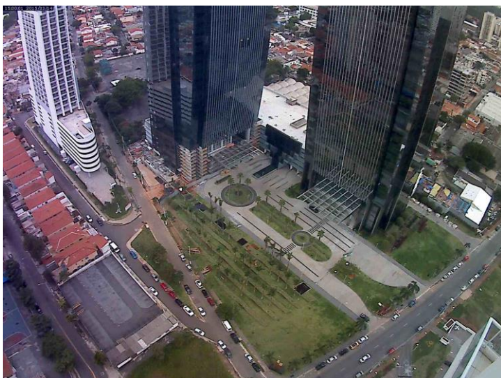
Foto Área de Acesso - EZ Towers em 14 de março de 2015
