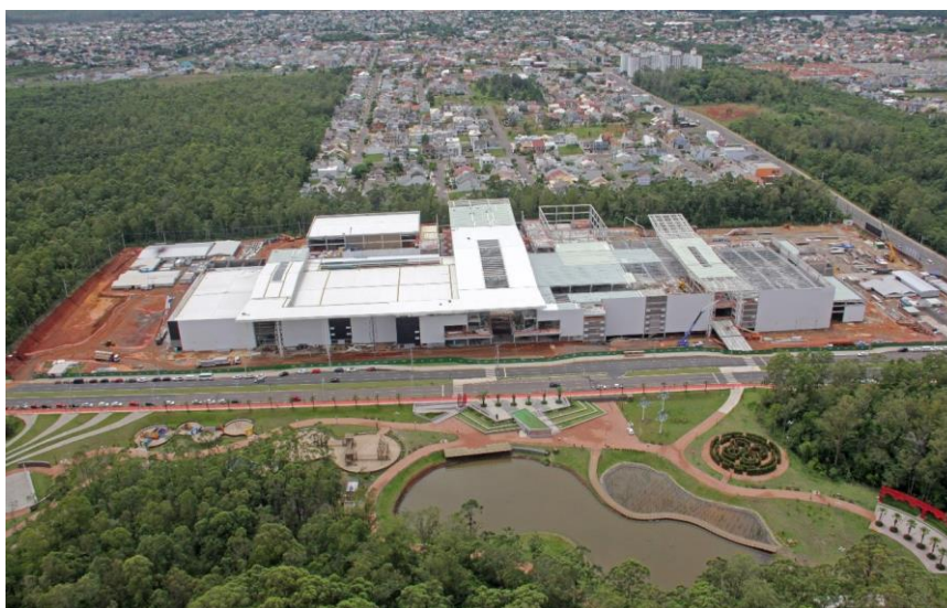
ParkShoppingCanoas em construção (dez-16)
