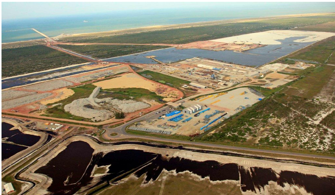
Vista geral da área LLX Minas-Rio no TX1
