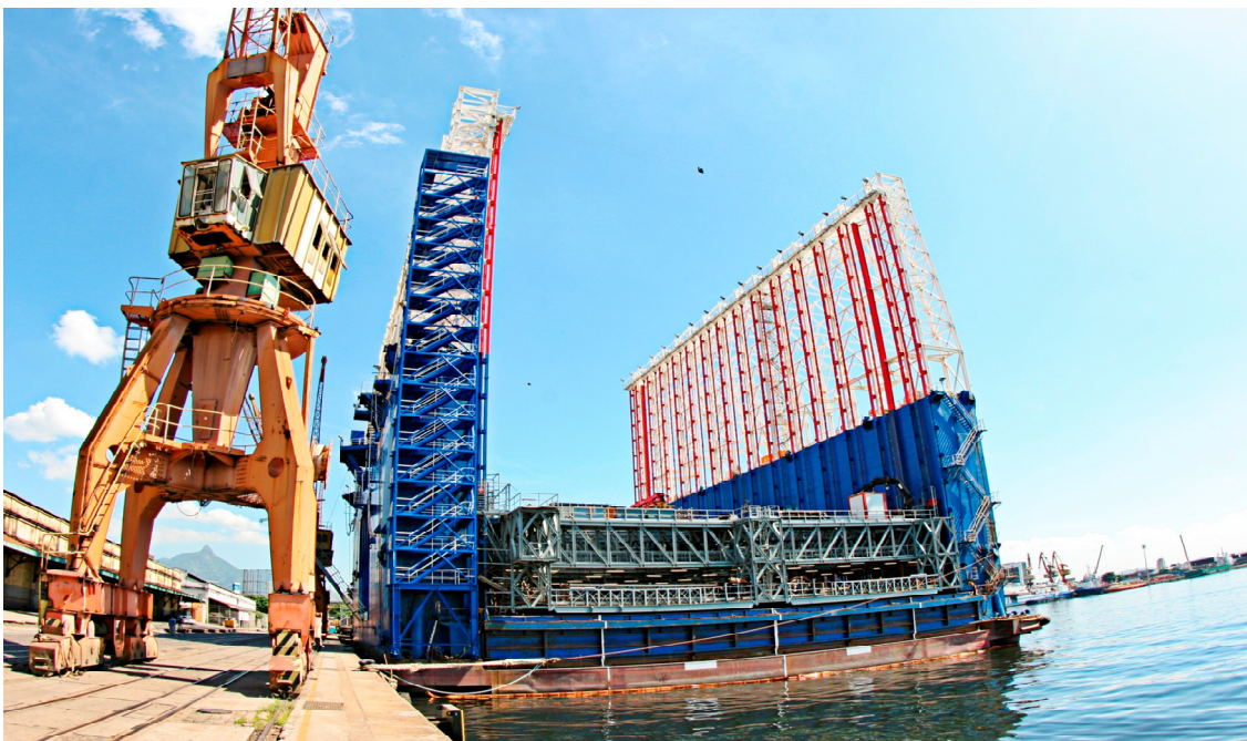
Maior construtor de diques de concreto do mundo
