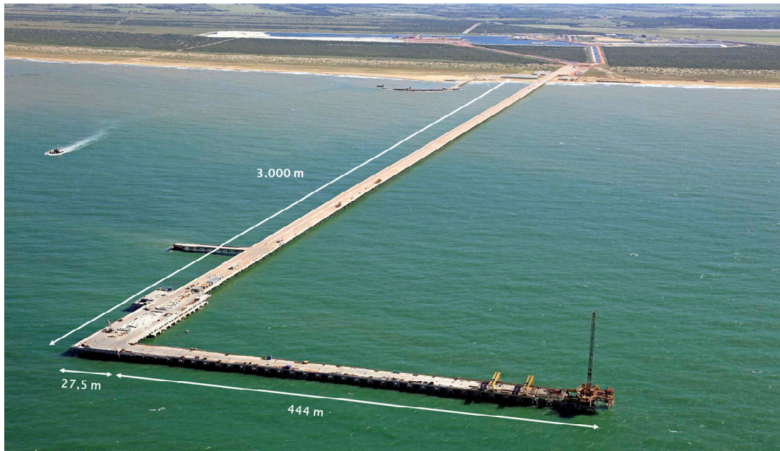
Vista geral da ponte de acesso ao TX1
