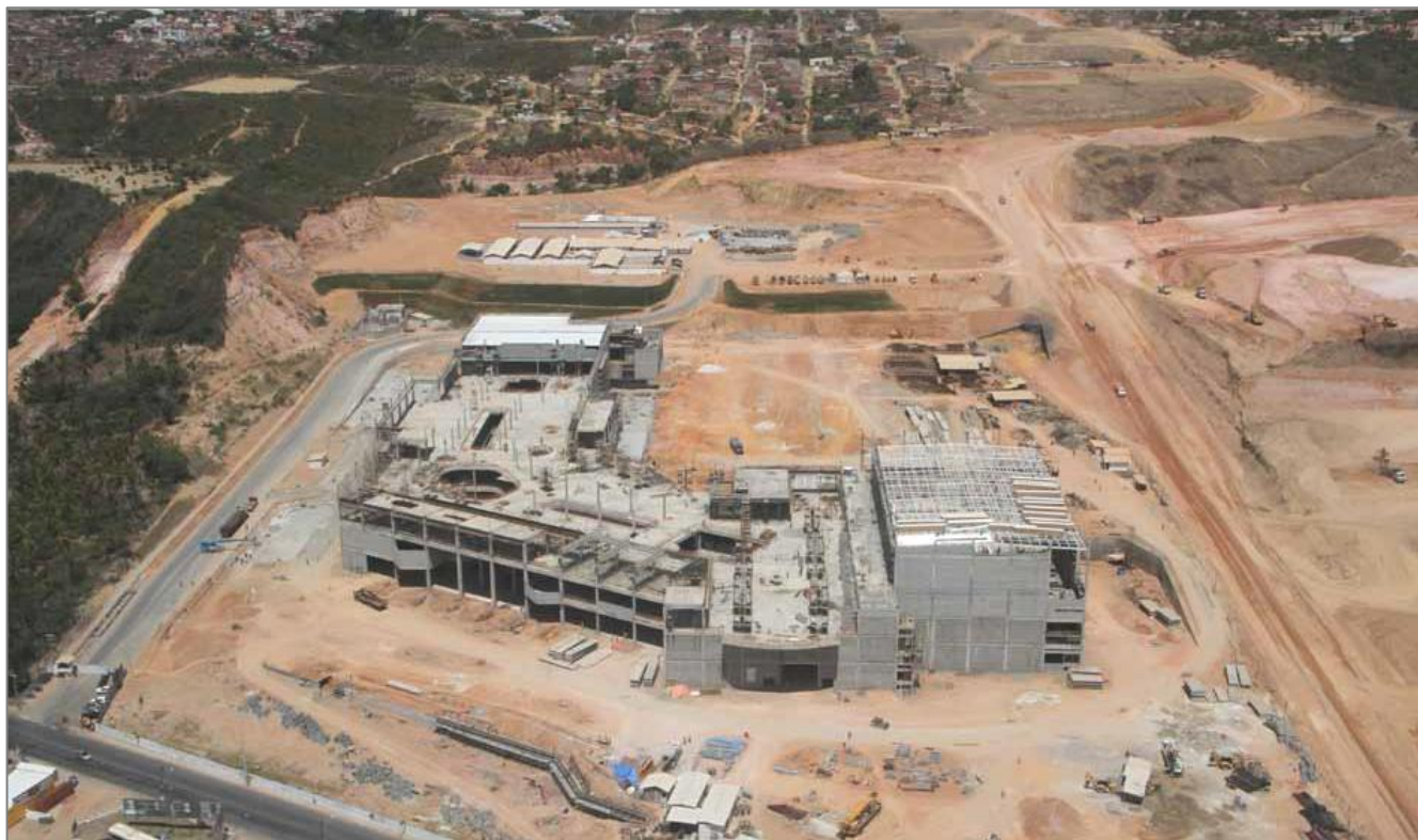
Parque Shopping Maceió – construção (Fevereiro 2013)
