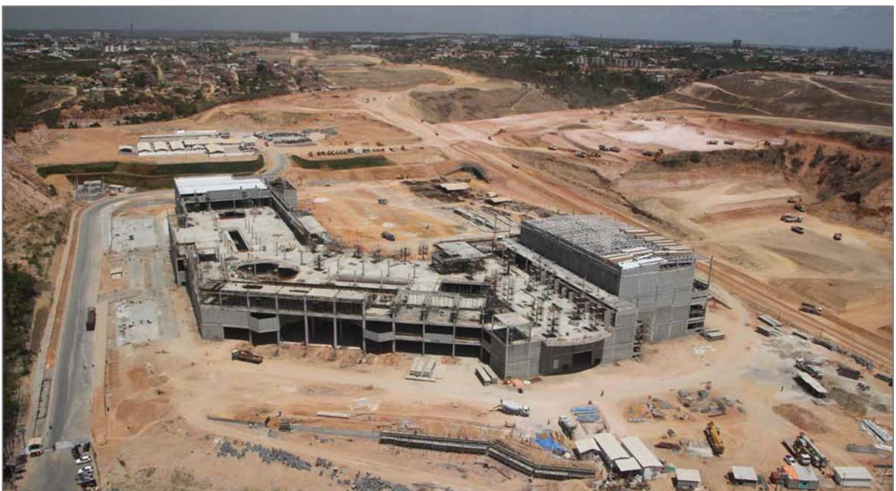
Parque Shopping Maceió – construção (Fevereiro 2013)
