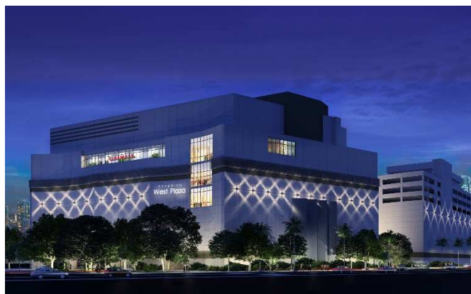
Nova fachada com o cinema no 4º piso
