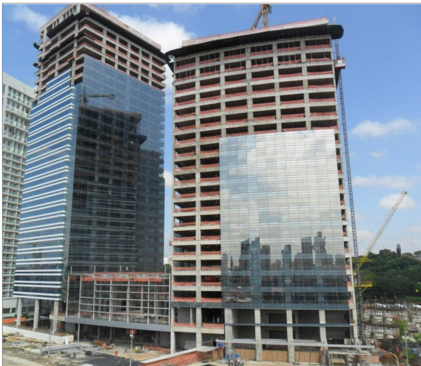
Morumbi Corporate – Construção (janeiro 2013)
