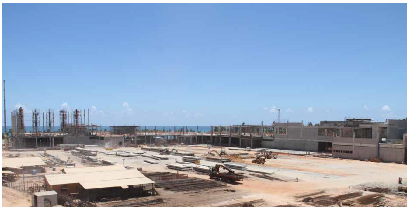
Parque Shopping Maceió – Construção (janeiro 2013)
