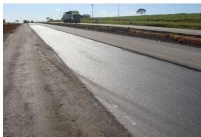
Duplicação BR101-RJ / Macaé – Campos (Autopista Fluminense)
