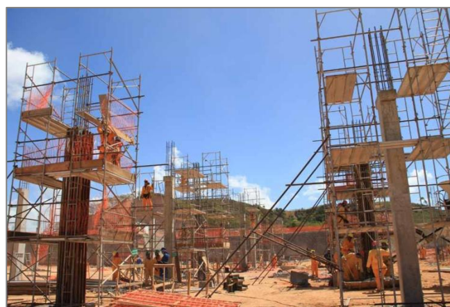
Construção (em abril de 2012)
