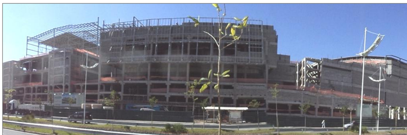
Construção (em abril de 2012)
