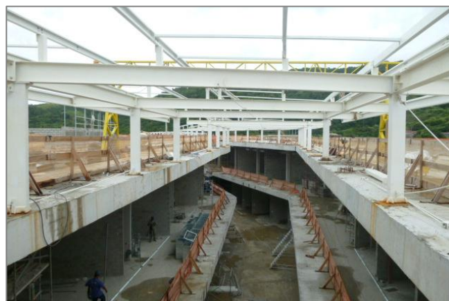
Construção (em abril de 2012)
