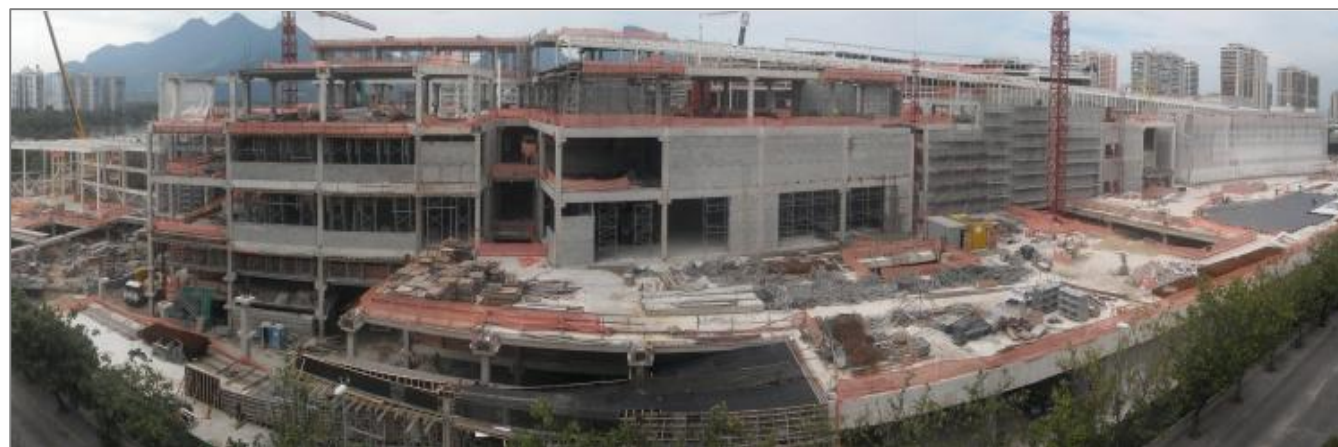
Construção (em abril de 2012)
