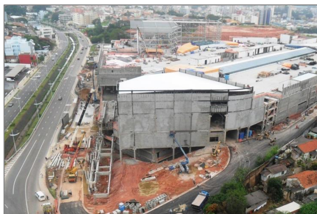
Construção (em abril de 2012)
