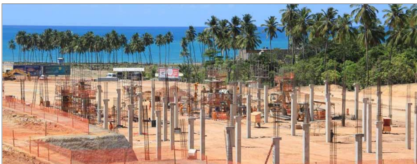
Construção (em abril de 2012)
