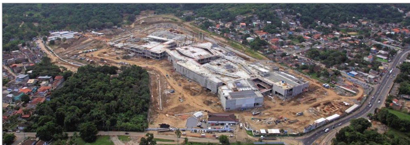
Construção (em abril de 2012)
