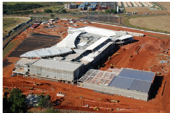
Obras do Uberlândia Shopping
