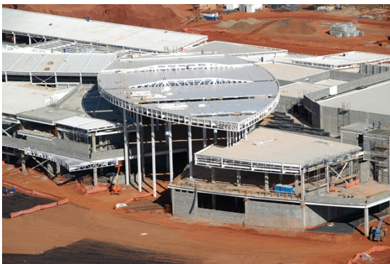
Obras do Uberlândia Shopping
