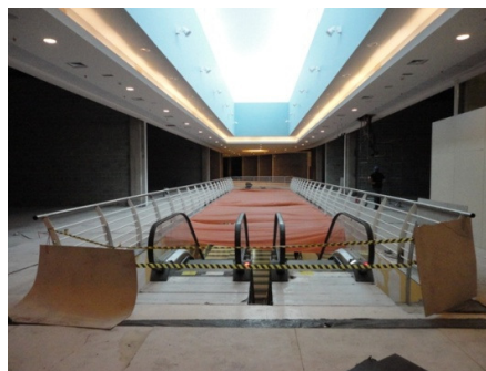
Obras de Expans o do Campo Limpo
