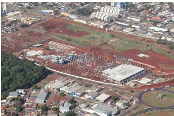
Obras do Projeto do Boulevard Londrina
