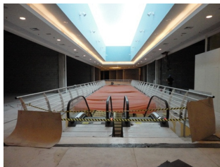
Obras de Expans o do Campo Limpo
