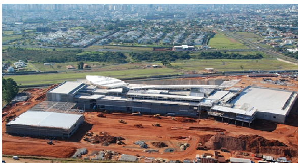
Obras do Uberlândia Shopping
