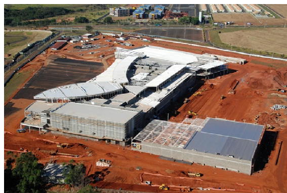
Obras do Uberlândia Shopping
