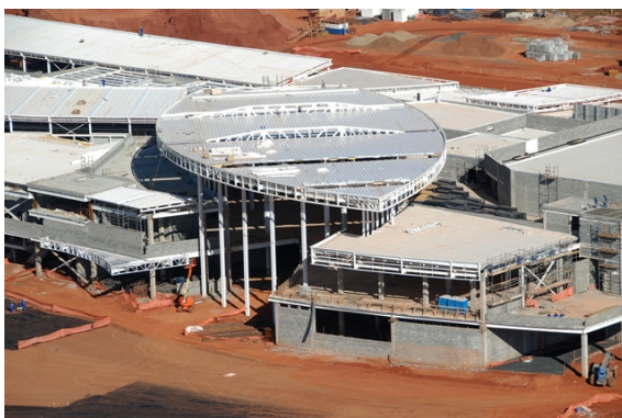
Obras do Uberlândia Shopping
