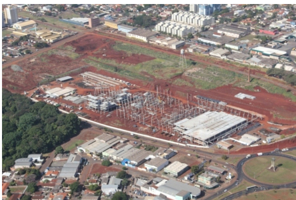
Obras do Projeto do Boulevard Londrina
