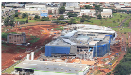
Obras do projeto do Boulevard Londrina
