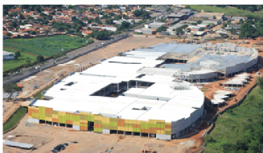
Obras do projeto do Passeio das Águas
