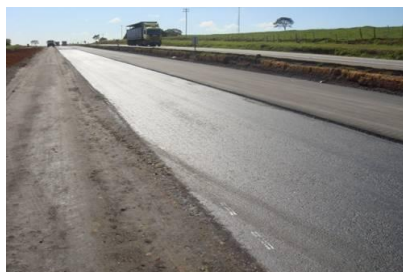
Duplicação BR101-RJ / Macaé – Campos (Autopista Fluminense)
