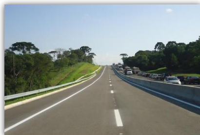
Duplicação da BR-116/PR (Autopista Planalto Sul)
