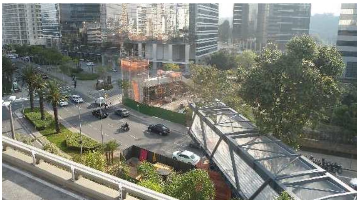
Passarela em construção – Complexo MorumbiShopping
