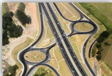
Duplicação BR101-RJ / Macaé – Campos (Autopista Fluminense)
