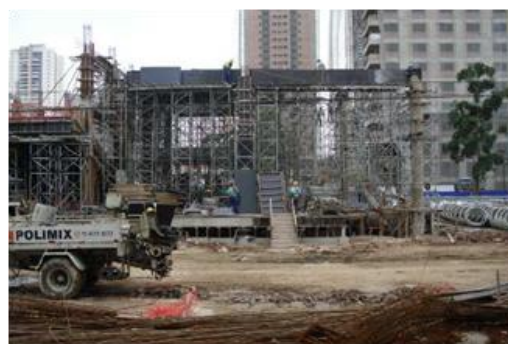
Obra de Expansão do MetrÓpole
