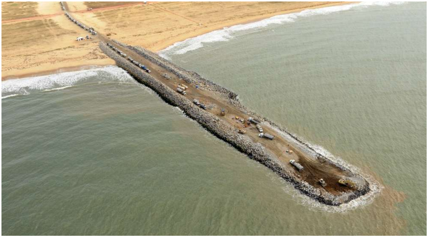
TX2: detalhe das obras no quebra-mar (molhe norte)
