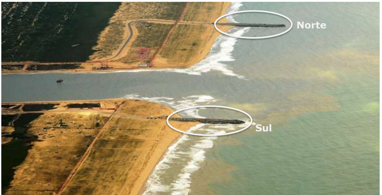
TX2: vista geral da construção do quebra-mar
