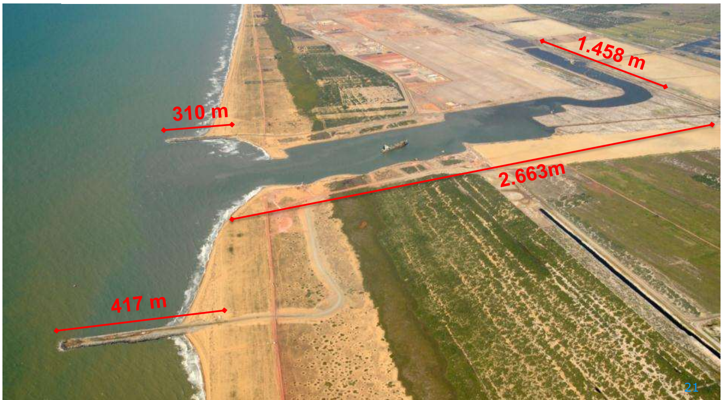
TX2: vista geral da construção do canal onshore
