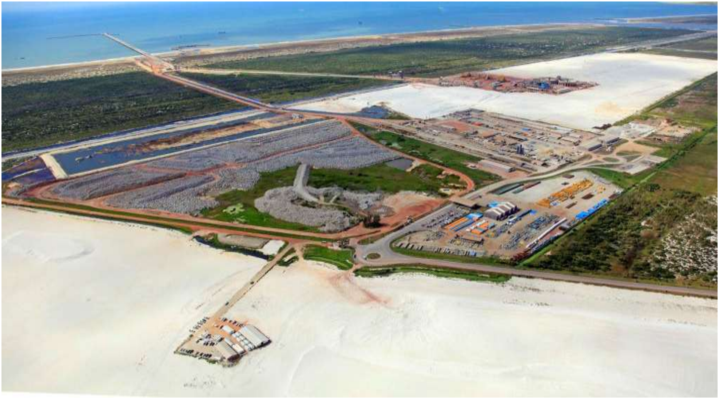
TX1: Vista Geral LLX Minas-Rio e UTP
