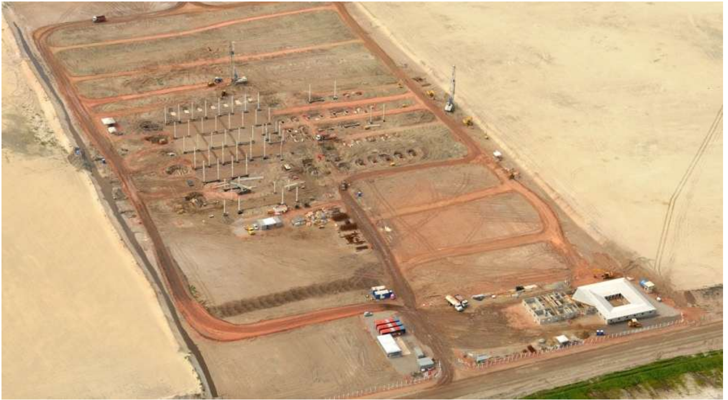
TX2: detalhe do início das obras da NOV
