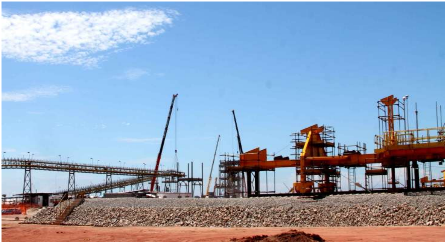
Montagem da Correia Transportadora
