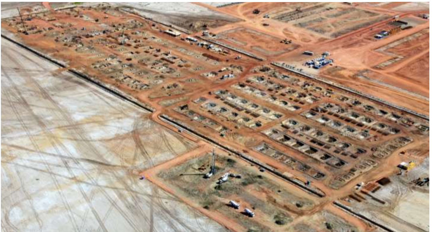
TX2: detalhe das obras Unidade de Construção Naval da OSX
