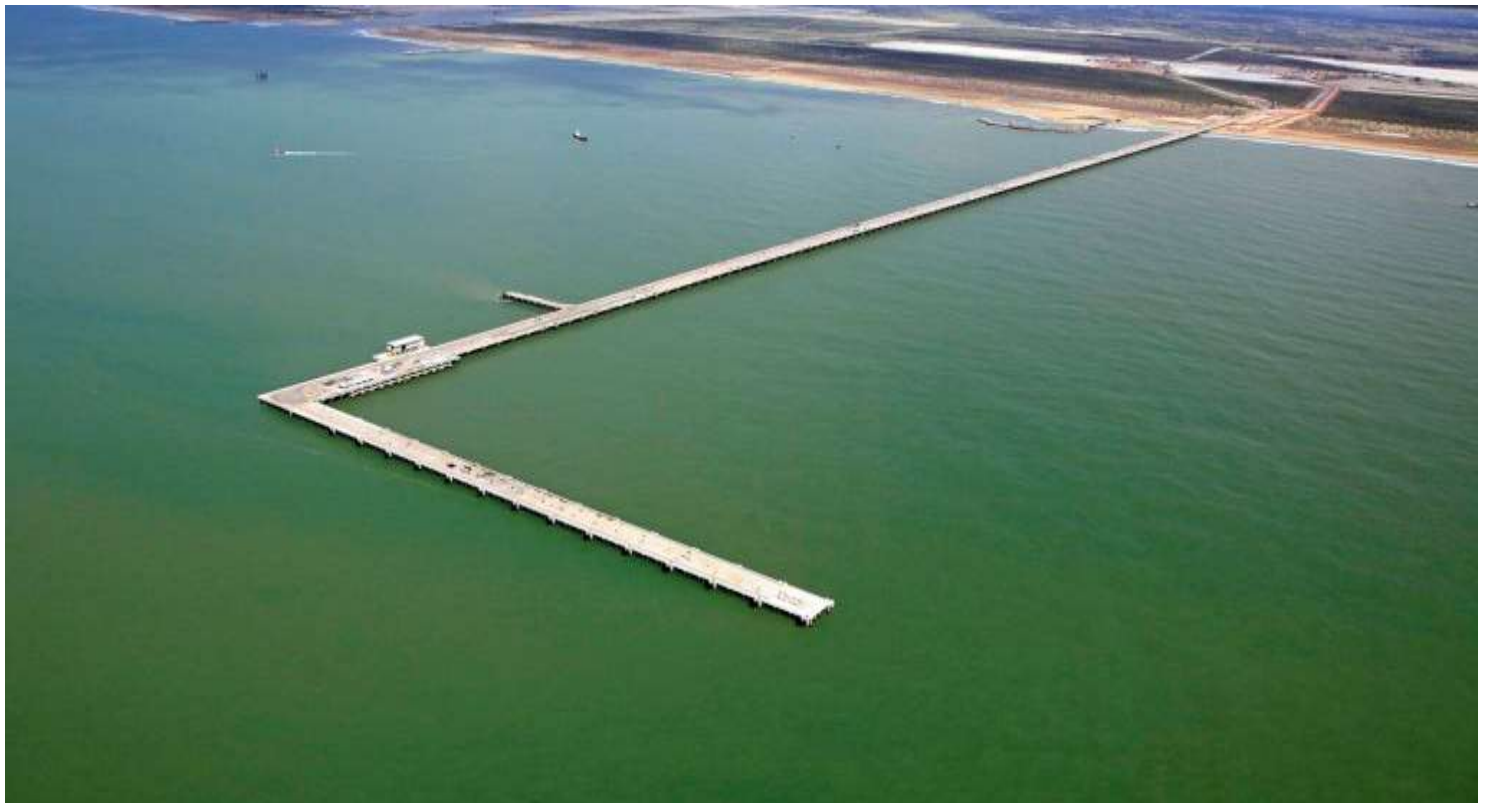
Vista aérea do Píer de Minério de Ferro
