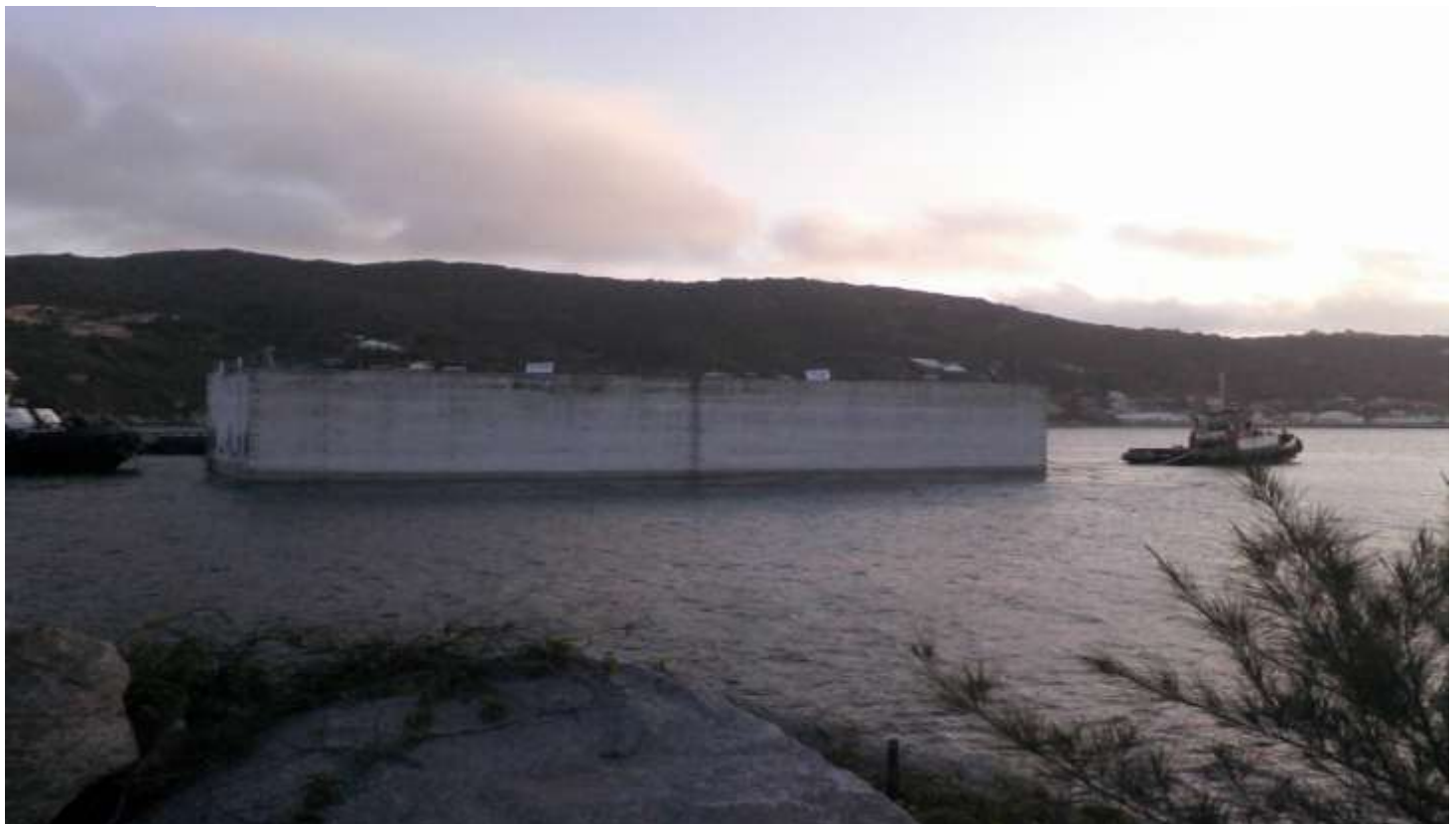
Detalhe do bloco de concreto em Arraial do Cabo
