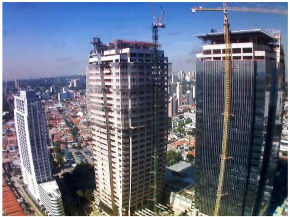
Foto do Canteiro de Obra - EZ Towers em 05 de maio de 2014
