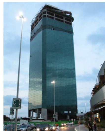
Fotos da Construção do Cristal Tower em Fevereiro de 2011
