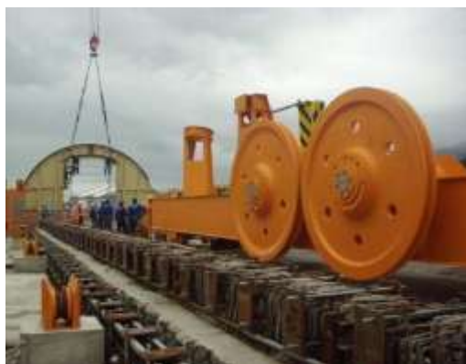
Montagem do virador de vagão
