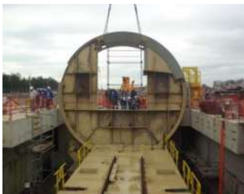
Montagem do virador de vagão
