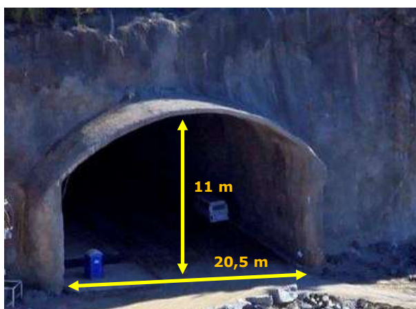
3) Entrada do Túnel
