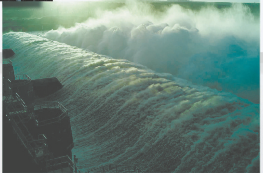
Usina Hidrelétrica de Tucuruí - Foto cedida pela Eletronorte
