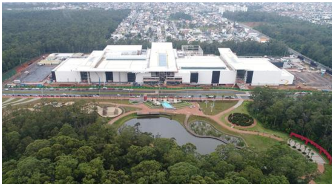
ParkShoppingCanoas em construção (jun-17)
