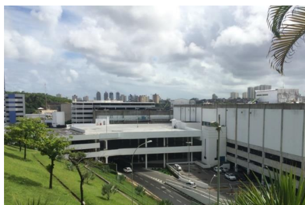
2ª Expansão – Interligação concluída em 31 de maio
