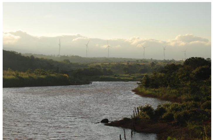
Barragem recuperada em Guanambi (Beira Rio)
