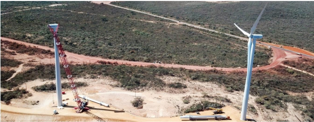
Instalação das torres e turbinas eólicas no Alto Sertão II
