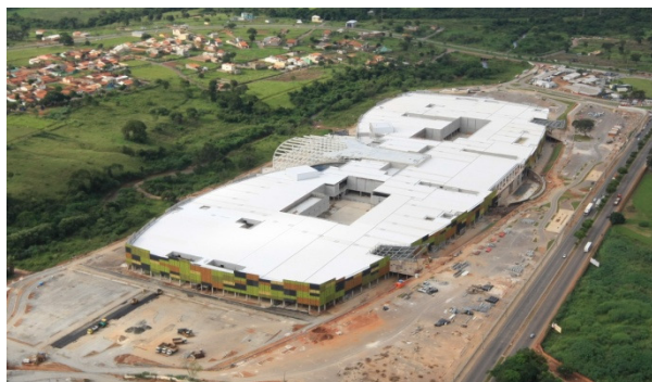
Obras do projeto do Passeio das Águas
