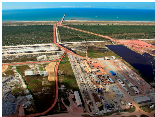
Vista aérea do canteiro de obras
