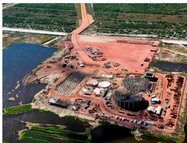
Planta de filtragem – LLX Minas Rio
