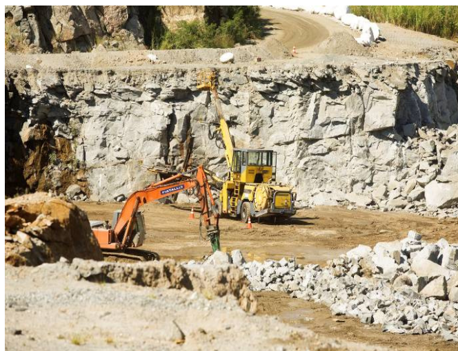
Superporto Sudeste – canteiro de obras
