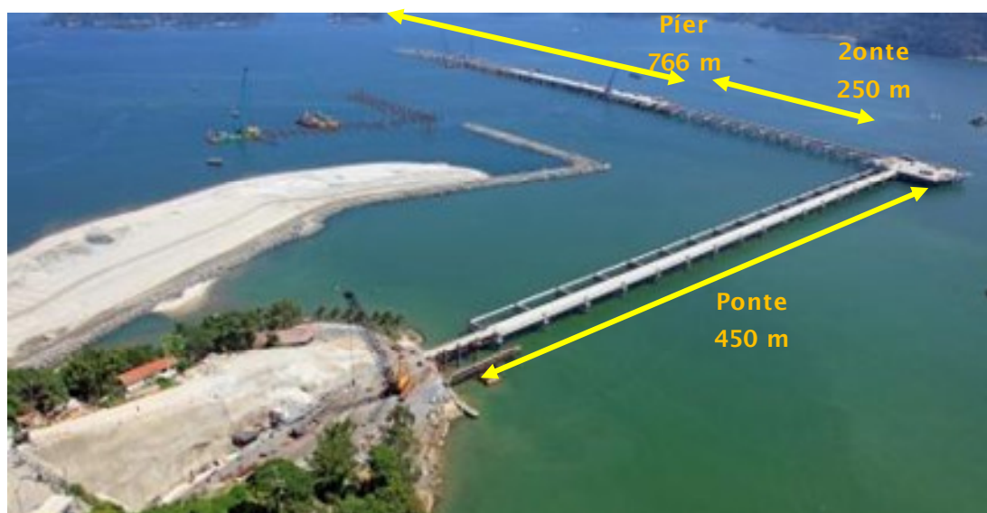
4) Estrutura marítima: Ponte e Píer
