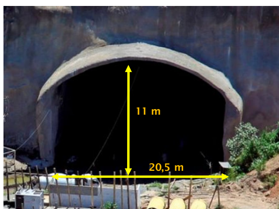
3) Entrada do Túnel
