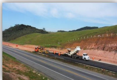
Duplicação BR101-RJ / Macaé – Campos (Autopista Fluminense)
