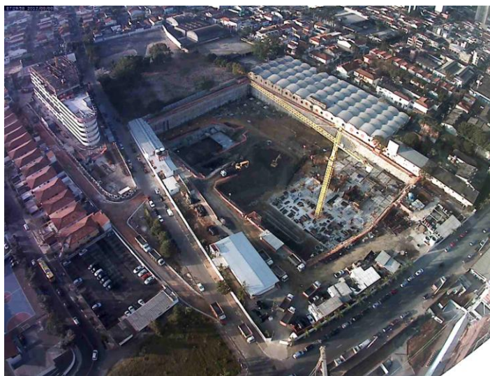
Foto do Canteiro de Obra EZTower dia 08 de Agosto de 2012
