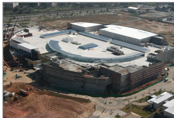
Foto da obra no 2T11
