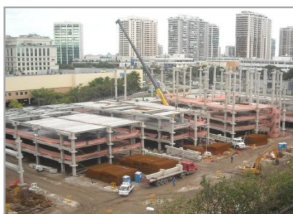
VillageMall (RJ) Foto das obras no 2T11
