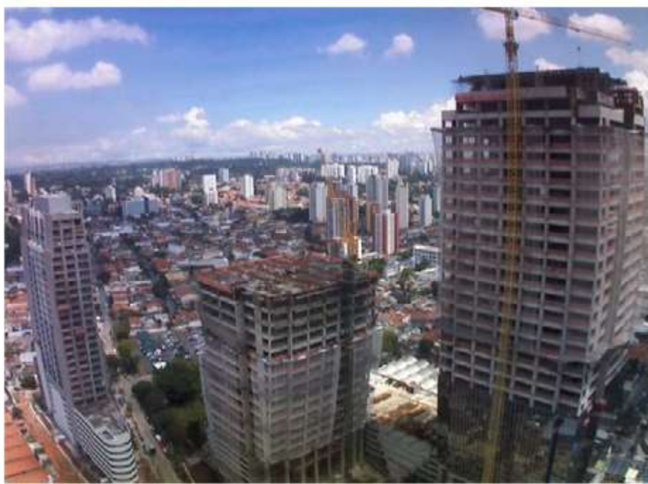
Foto do Canteiro de Obra EZ Towers em 08 de novembro de 2013
