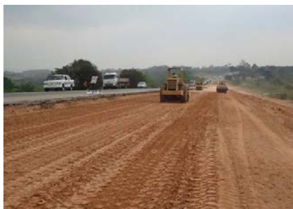
Duplicação BR-116/PR – Fazenda Rio Grande (Autopista Planalto Sul)
