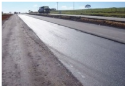
Duplicação BR101-RJ / Macaé – Campos (Autopista Fluminense)
